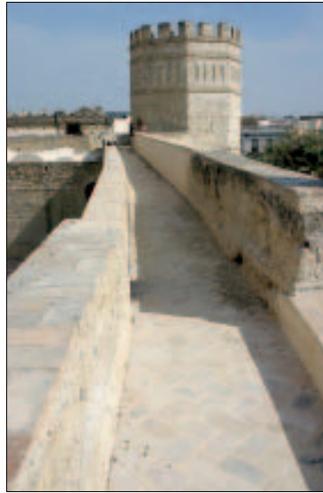
Derzeit (noch) nicht zugänglich: Torre Octogonal
